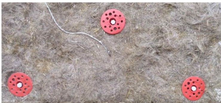
Рис. 9. Монтаж утеплителя на кирпичной стене
